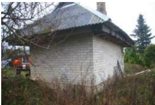
Būve (pirts ēka) ar kadastra apzīmējumu 6464 004 0044 004
