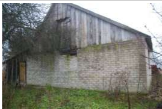
Būve (saimniecības ēka) ar kadastra apzīmējumu 6464 004 0044 003
