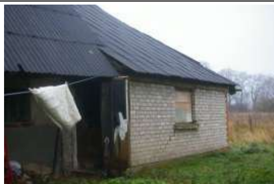
Būve (saimniecības ēka) ar kadastra apzīmējumu 6464 004 0044 003
