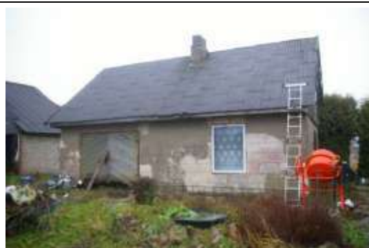
Būve (garāžas ēka) ar kadastra apzīmējumu 6464 004 0044 002
