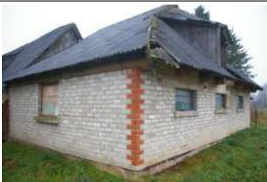
Būve (saimniecības ēka) ar kadastra apzīmējumu 6464 004 0044 003
