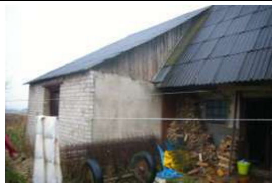
Būve (saimniecības ēka) ar kadastra apzīmējumu 6464 004 0044 003
