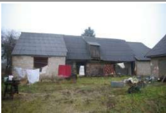
Būve (saimniecības ēka) ar kadastra apzīmējumu 6464 004 0044 003
