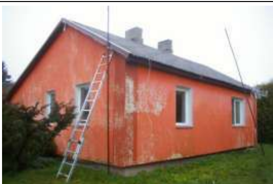
Būve (dzīvojamā ēka) ar kadastra apzīmējumu 6464 004 0044 001
