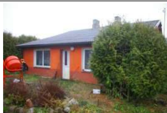
Būve (dzīvojamā ēka) ar kadastra apzīmējumu 6464 004 0044 001
