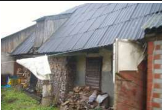
Būve (saimniecības ēka) ar kadastra apzīmējumu 6464 004 0044 003
